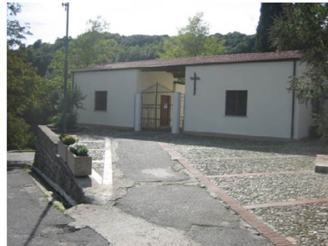
Cimitero dopo gli interventi
