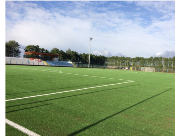
Campo sportivo dopo degli interventi
