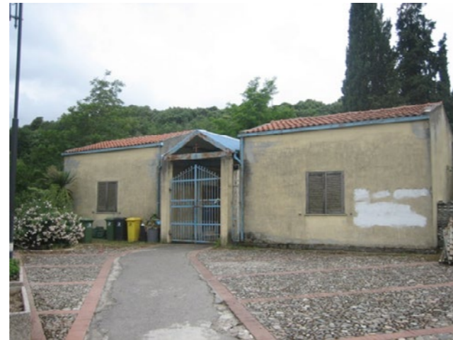
Cimitero prima degli interventi
