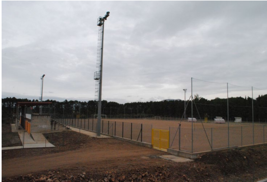
Campo sportivo prima degli interventi
