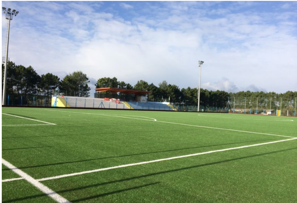
Campo sportivo dopo degli interventi
