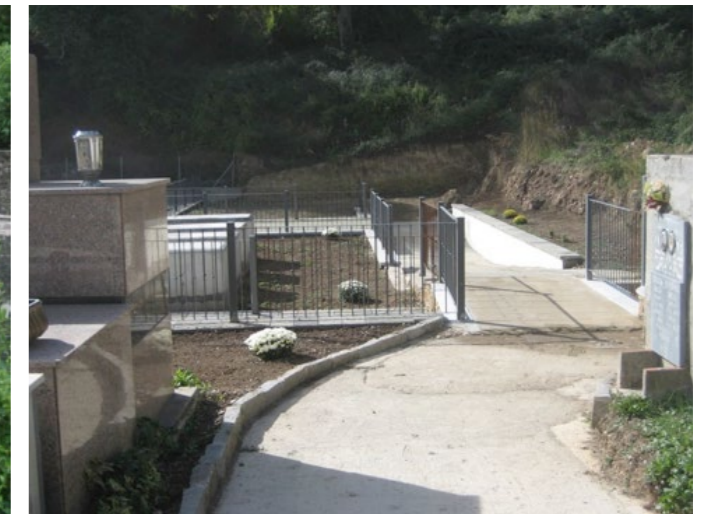
Cimitero dopo gli interventi
