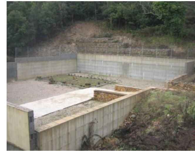
Cimitero prima degli interventi
