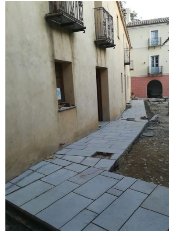
Ultimi lavori in fase di conclusione
