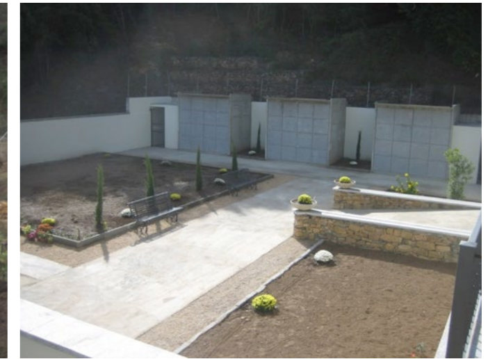
Cimitero dopo gli interventi
