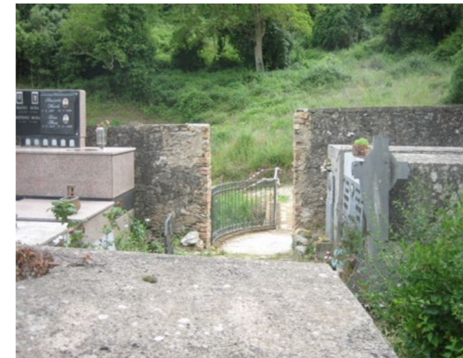
Cimitero prima degli interventi
